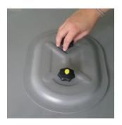
Den Revisionsdeckel gerade drehen, zum exakten positionieren leicht von der Kanalwand wegziehen und die Sterngriffe fest anziehen.
